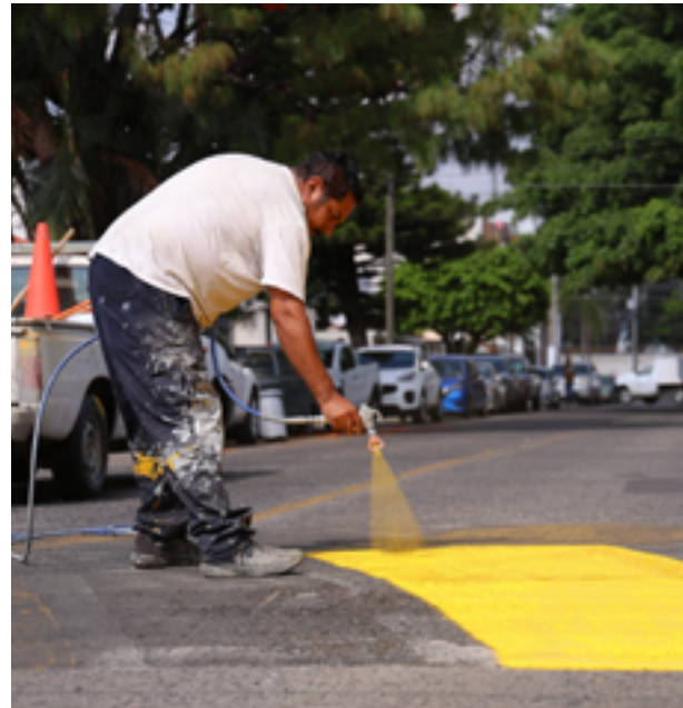
Mantenimiento de vialidad
