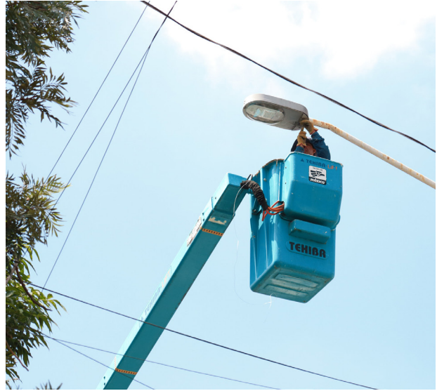
FOTO: Cambio de luminarias
