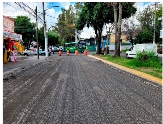
FOTO: Mantenimiento vial
