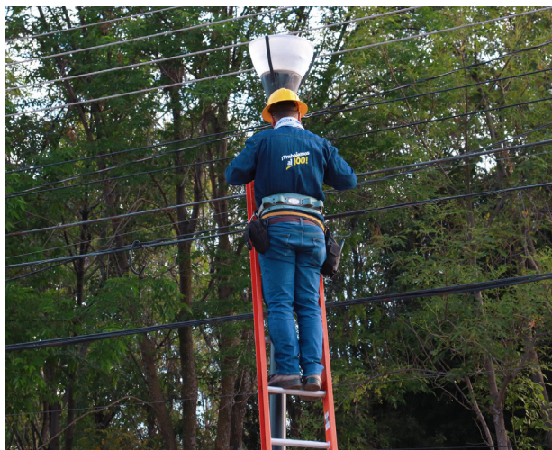
FOTO: Cambio de luminarias
