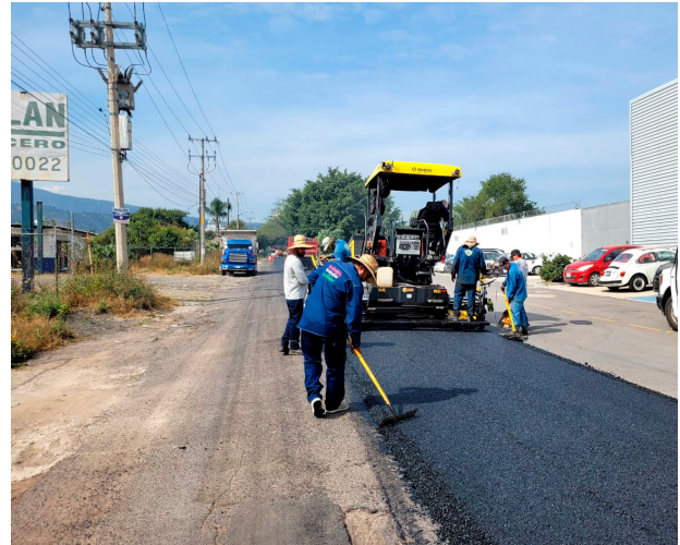
FOTO: Mantenimiento vial
