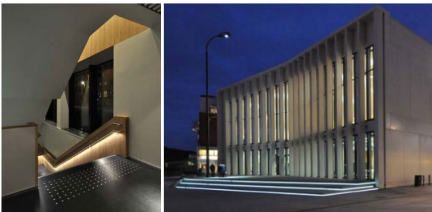
Figur 28: Bodø: inngangspartiet og trapper i kulturkvartalet er belyst for å gjøre det enklere å orientere seg og komme seg rundt i bygget
