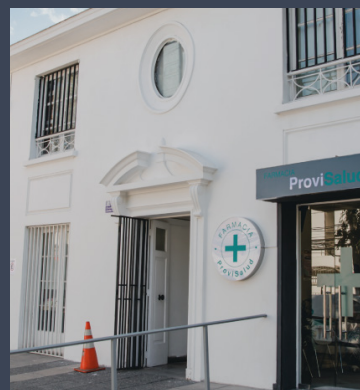
Figura 23: Fachada Farmacia Comunitaria. Fuente: providencia.cl
