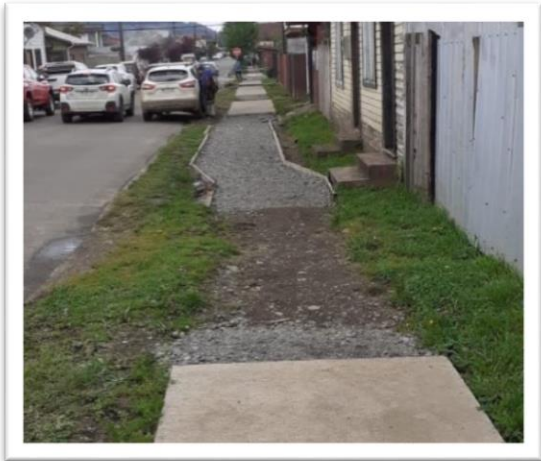
IMAGEN: CALLES EN MANTENCIÓN.
