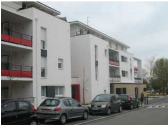
Rue du Marquis de Dion
